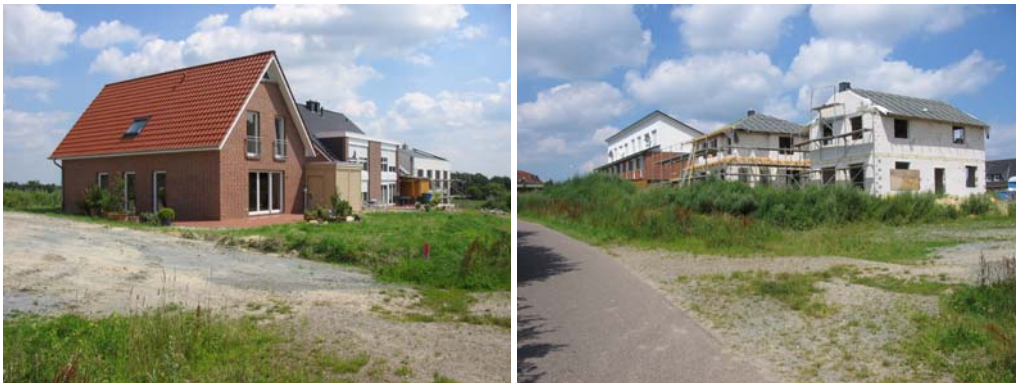
Abb. 36: Baugebiet „Grünenkamp“ im Ortsteil Scharmbeck (Fotos: FORUM GmbH, Juli 2007)
